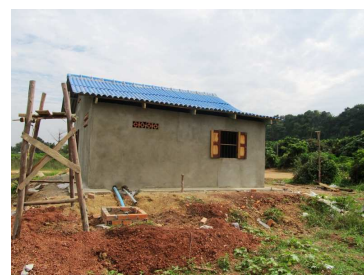
建設中の教職員宿舎
